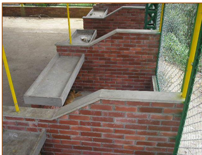
Foto 3. Instalaciones e infraestructura plaza de mercado.
